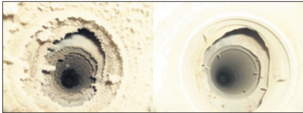
SAUNAN poistoilmakanava ennen ja jälkeen puhdistuksen.
